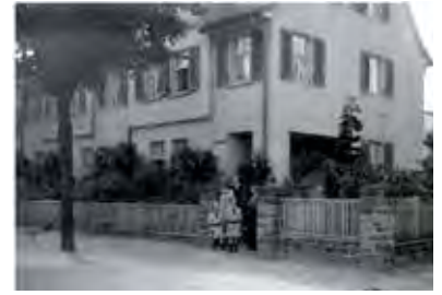
Doppelhaus Hauptstraße 223/235 mit Einzäunung
