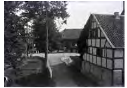
Neben der Sülz wurde das alte ‚Müllenbachs Brückenhaus‘ 1926 abgerissen
