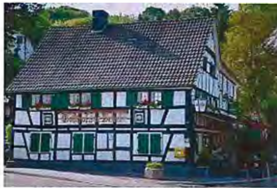
12 Gasthaus "Zur Brücke", Hauptstr. 215
