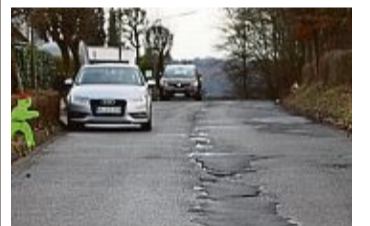
Recht ausbaufähig ist der Zustand der Rappenhohner Straße.
