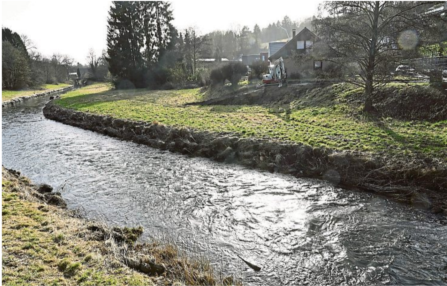
Die Sülz soll in Rösrath an einer Stelle verbreitert werden – an einer anderen soll Bauland entstehen.
