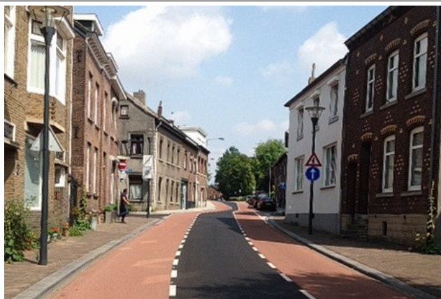
Schutzstreifen in Meerssen (NL) ... ... konsequent in 1,80 m Breite durchgezogen - auch im Bereich sehr enger Fahrbahnstellen
