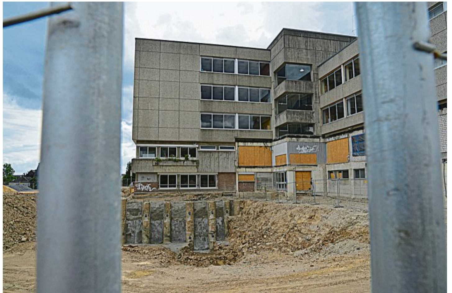
Ins Stocken gerieten die Bauarbeiten am Freiherr-vom-Stein-Schulzentrum im August. Inzwischen kommen sie gut voran.
