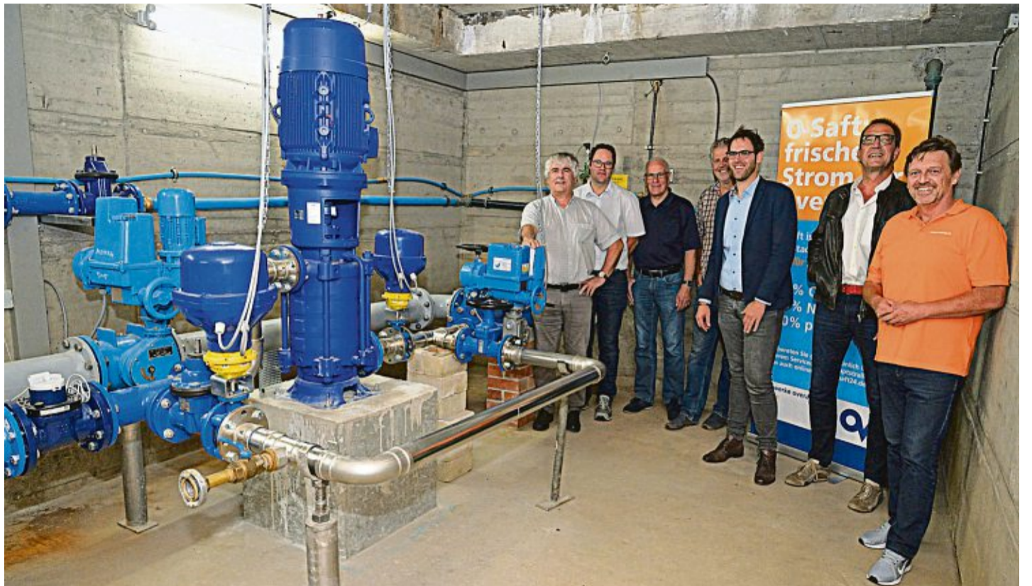
Im August nehmen die Stadtwerke Overath die Wasserkraftturbine „Blaue Berta“ in Betrieb.
