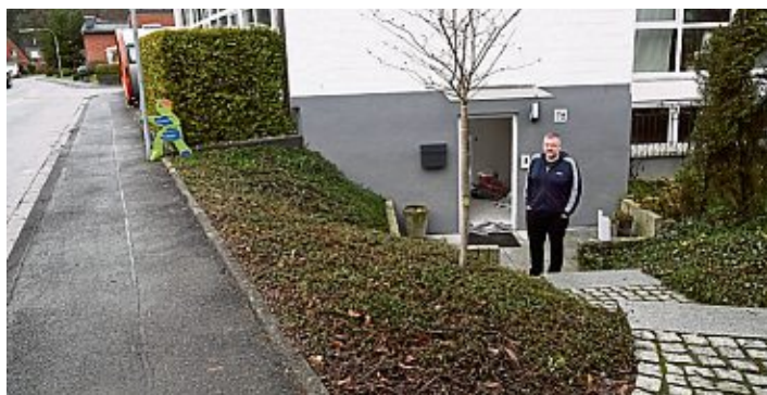
Im Souterrain des Familienhauses von Brian Müschenborn stieg das Wasser bis zur Decke der Kinderzimmer. Fotos: Arlinghaus
