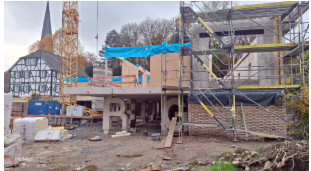
Abb.2: Baustelle Kita-Volberg; vorbildlich auf Stelzen – ohne Versiegelungen und Retentionsflächen-Wegnahme
