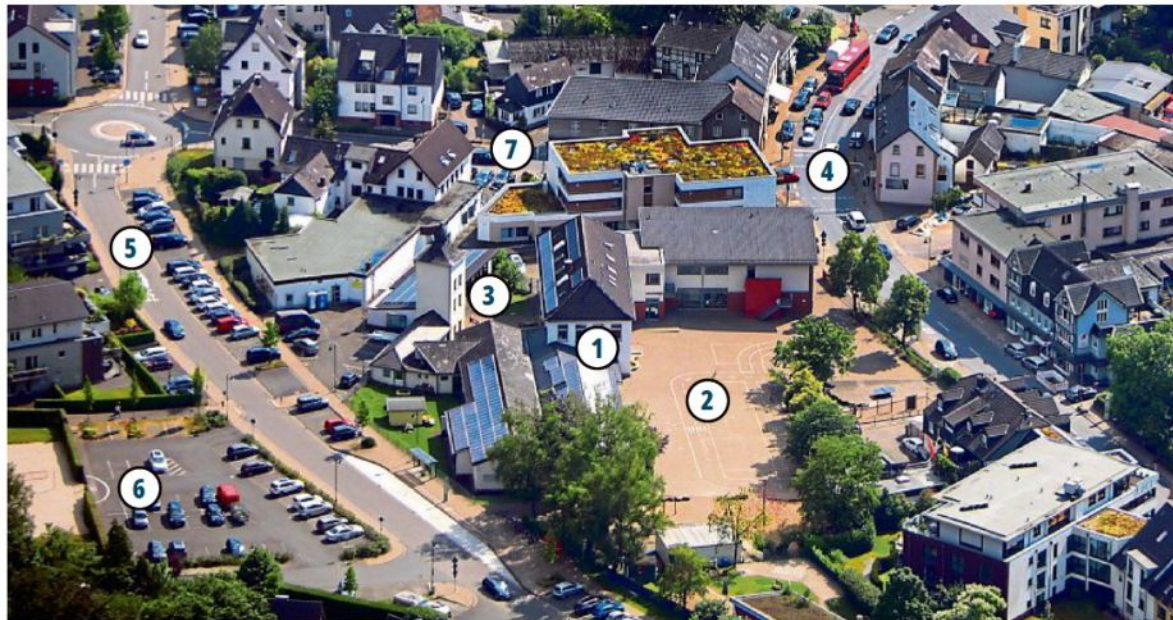
Mitten im Ort befindet sich die Hoffnungsthaler Grundschule (1), auf deren Schulhof (2) samstags der Wochenmarkt stattfindet und hinter der sich früher das Feuerwehrgerätehaus samt Schlauchturm (3) befand. Auf der einen Seite grenzt das Gelände an die Hauptstraße (4) an, auf der anderen an die Rotdornallee, an der sich gegenüber auch der Parkplatz (6) des Freibads befindet. Nicht weit entfernt: die Verkehrsachse Hofferhofer Straße (7). Fotos: Guido Wagner
