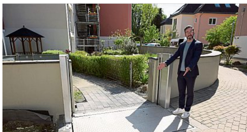
Auch eine Mauer im Innenhof wird bei Flut durch Metallteile abgedichtet.
