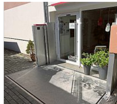
Im Normalbetrieb ist die Edelstahl-Wand heruntergefahren.
