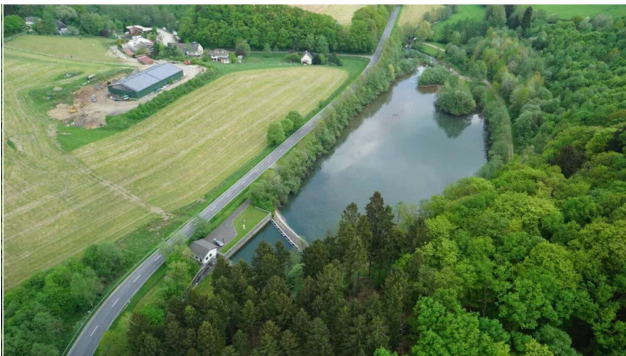
Die Sülzüberleitung im Luftbild (Bildquelle: Webseite Wupperverband)
