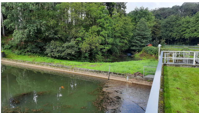
Wehr (li.) und Überlaufbauwerk (re.)
