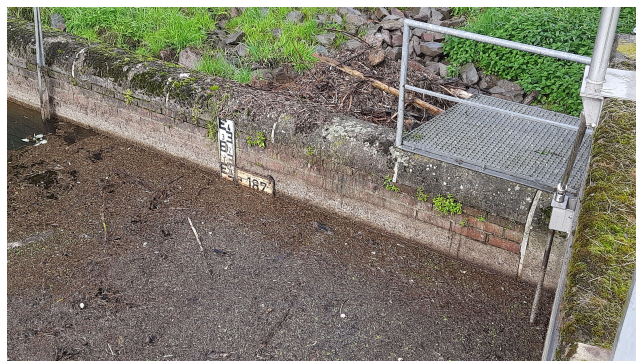
Überlaufwehr zur Sülz bei 187,62 müNN
