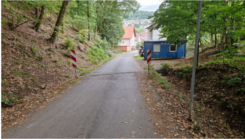
Niedrige Schwelle leitet das Regenwasser in den Regenwasserkanal
