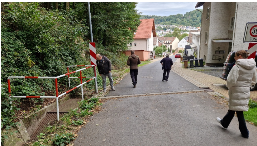
Regenwassereinlaufbauwerk
